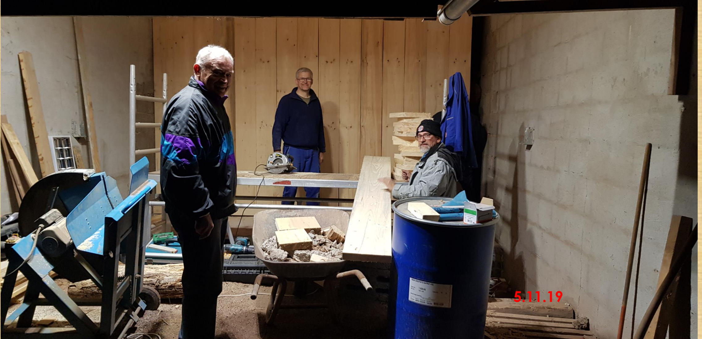
Bohlenwand kurz vor Fertigstellung
